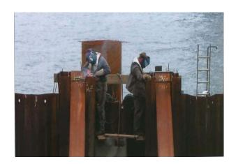
Самозащитная порошковая проволока марки Coreshield 8 для высокопроизводительной дуговой сварки ответственных изделий из конструкционных низкоуглеродистых и низколегированных сталей.
